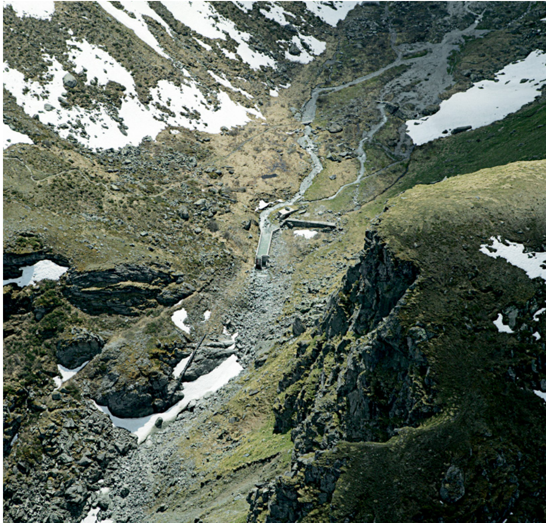
Wasserfassung am Grund der Schlucht von Prafleuri.
