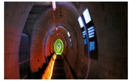
Führung im Innern der Staumauer
