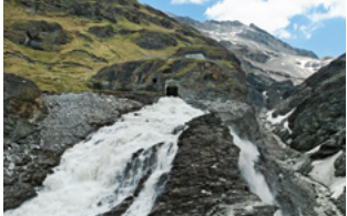
Austritt der Sammelstollen bei Cheilon
